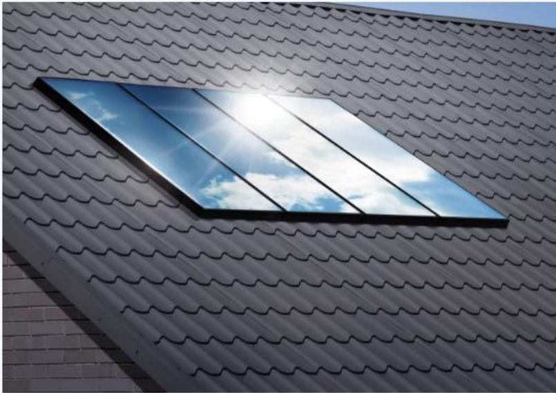
Solare termico per produzione di acqua calda sanitaria e integrazione riscaldamento
